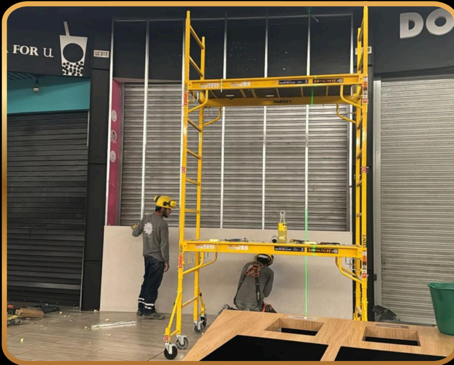
CONSTRUCCIÓN DE CERRAMIENTO PARA LOCALES DE CENTRO COMERCIAL COLINA
