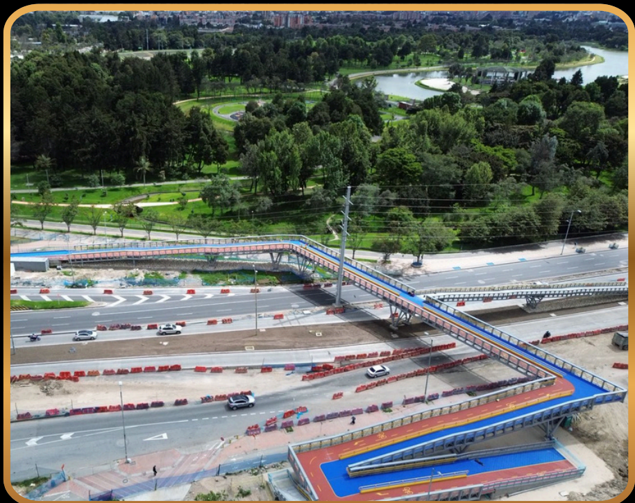
REPARACIÓN DE FISURAS Y RECUBRIMIENTO ACRILICO PARA CICLO PUENTE AV 68
