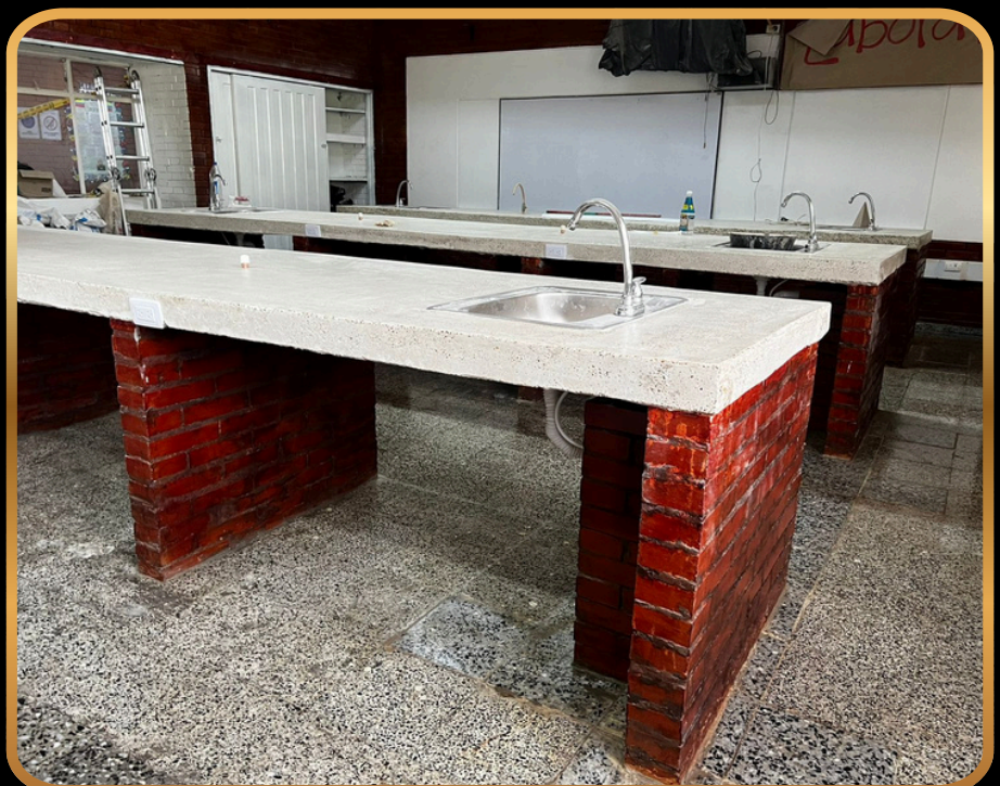
CONSTRUCCIÓN AULA DE FISICA COLEGIO JOSE FELIX RESTREPO
