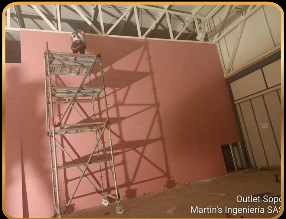
CONSTRUCCIÓN DE MURO CORTAFUEGO PARQUE ARAUCO SOPÓ
