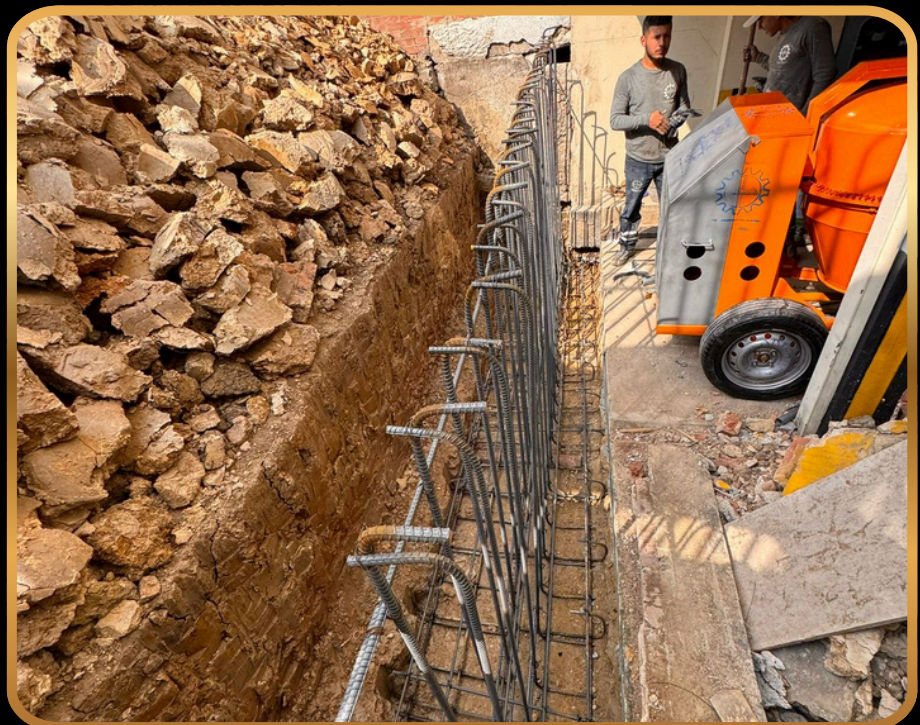
CONSTRUCCIÓN DE MURO DE CONTENCIÓN EN MULTIFAMILIAR VILLA MAYOR BOGOTÁ
