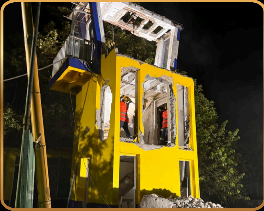
DEMOLICIÓN TORRE DE CONTROL NUQUI CHOCO
