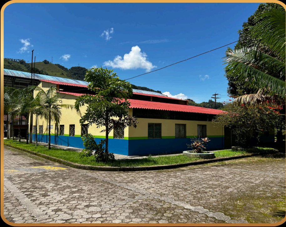
RESTAURACIÓN DE OFICINAS DE GESTION DEL RIESGO EN SANTA MARIA BOYACA
