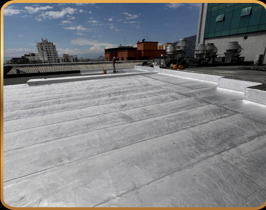
IMPERMEABILIZACIÓN DE CUBIERTA EN CENTRO COMERCIAL PARQUE ARBOLEDA PEREIRA
