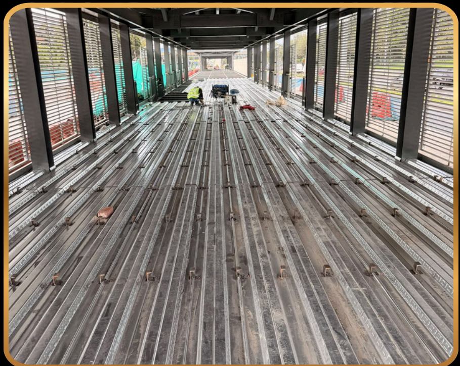
SUMINISTRO E INSTALACIÓN DE LAMINA COLABORANTE CALLE 66
