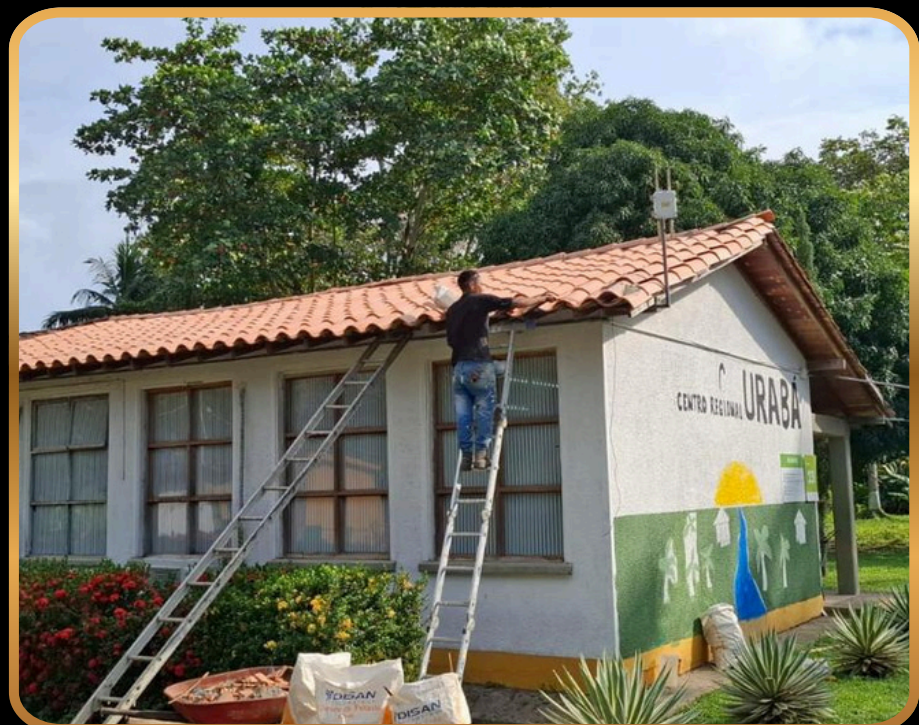
INTERVENCIÓN DE CUBIERTAS POLITECNICO COLOMBIANO JAIME ISAZA
