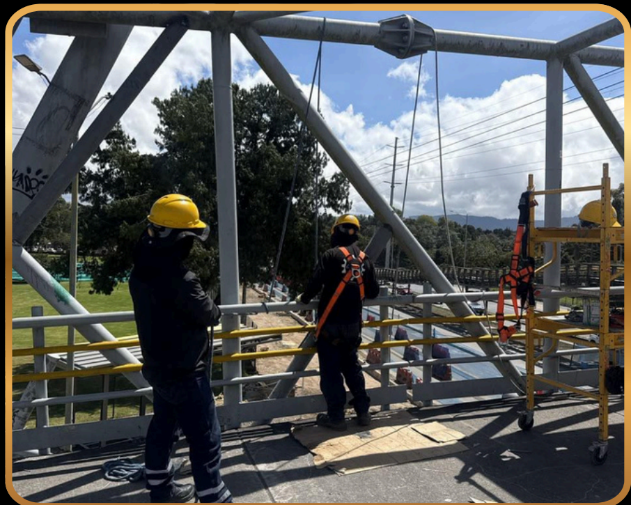
REFORZAMIENTO ESTRUCTURAL PUENTE AV 68
